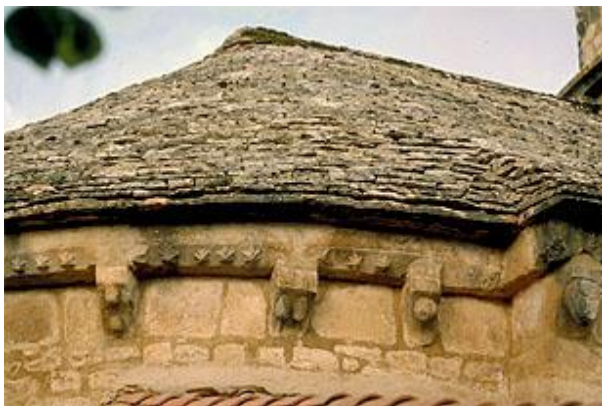
Toiture en pierre
